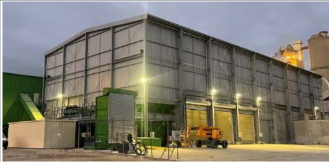
Almacén de combustible alternativos
