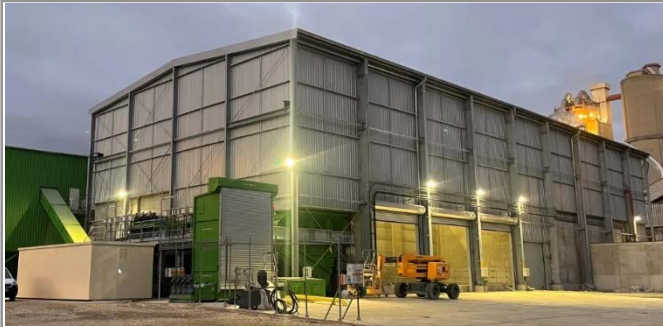
Almacén de combustible alternativos
